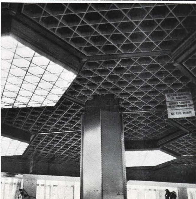
Detalle de techo. Rejillas en madera de contrachapado.
