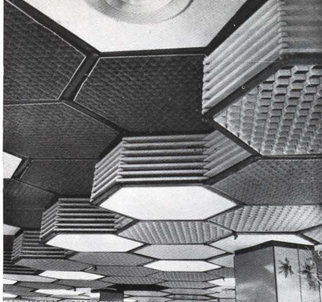
Detalle de techo. Rejillas de chapa, de aluminio y de hierro.
